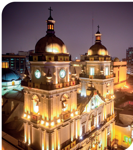
ILUMINACIÓN DE LA IGLESIA SAN PEDRO
